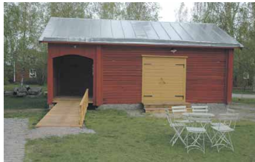
Att tillhandahålla utrymmen och framkomlighet för rörelsehindrade är en målvedveten satsning vid Stundars.
